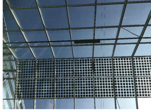
ČVUT v Praze, Fakulta stavební Zastřešení atria s integrovanou fotovoltaikou, která stíní Foto: J. Tywoniaková
