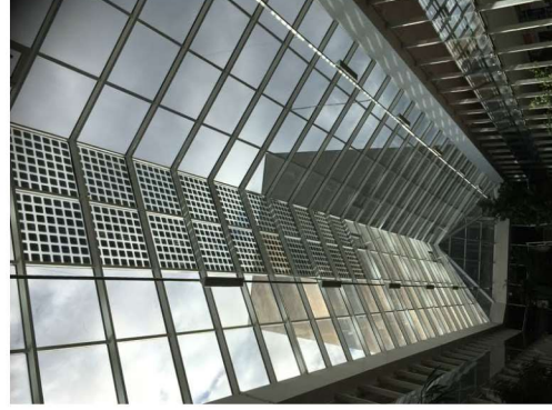
ČVUT v Praze, Fakulta stavební Zastřešení atria s integrovanou fotovoltaikou, která stíní Foto: J. Tywoniaková
