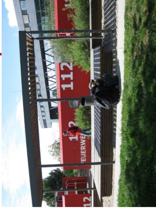
Heidelberg, Německo Ocelová pergola se dřevěnými lamelami stínící venkovní pódium Foto: Jana Tywoniaková
